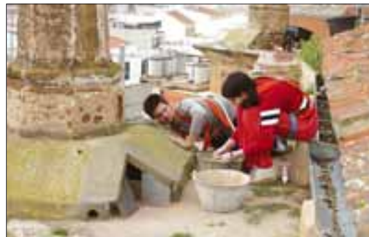
Dos voluntarios instalando nidales en la iglesia de la Purificación
