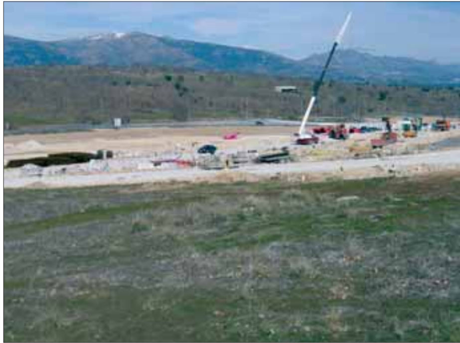
Obras de construcción de la urbanización Los Pinarejos, en Madrid
