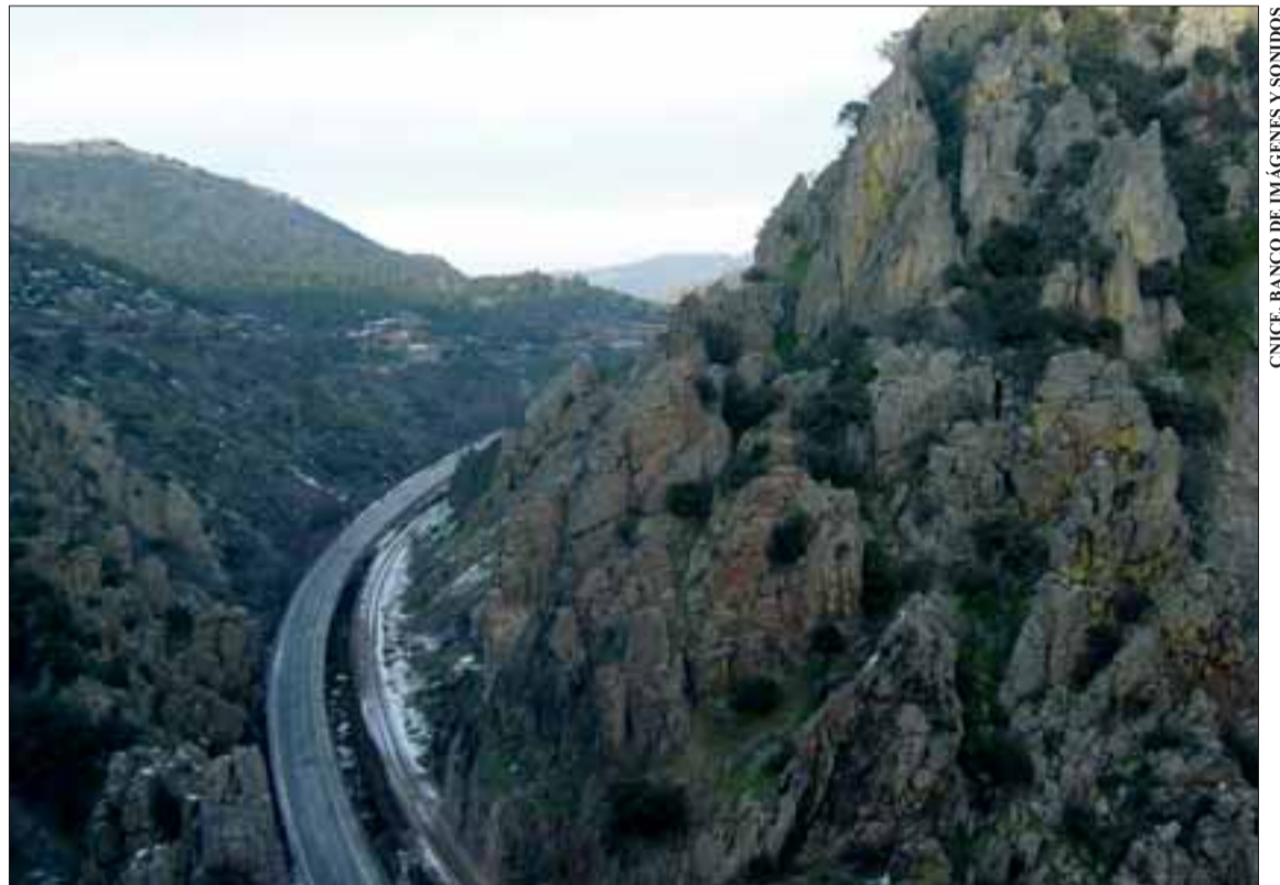
La autovía A4 a su paso por Despeñaperros
