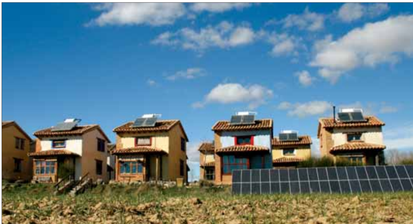
Viviendas unifamiliares bioclimáticas, construidas con adobe y alimentadas con energía solar
